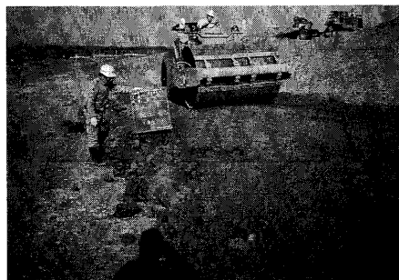
写真-2 転 圧 状 況
