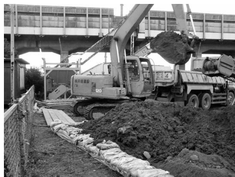
写真-4 改質土の積込状況
