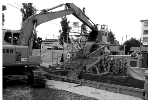
写真-2 泥土投入状況
