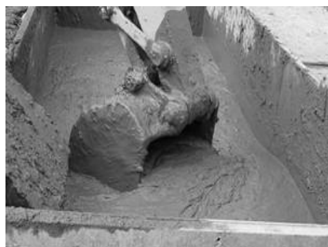
写真-1 貯泥状況(泥土圧シールド)
