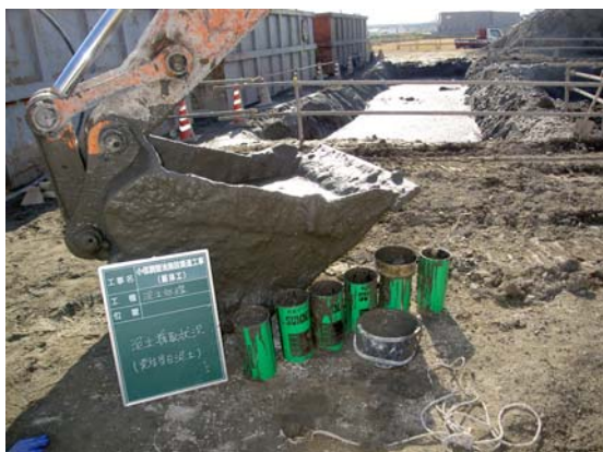
写真-1 TRD工法排泥採取状況
